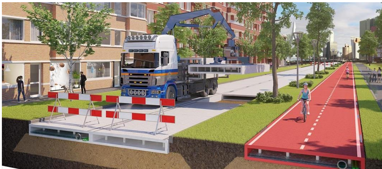
Рисунок 1. Укладка пластиковых дорожных покрытий
